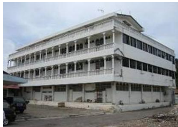
(b) Bangunan Gedung Suka Fajar menggunakan dinding yang masih berdiri pasca gempa.
